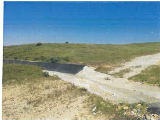
Fossés préexistants de collecte des eaux pluviales
